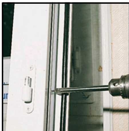
1. Percer la menuiserie Ø8,5 à 9 mm.
