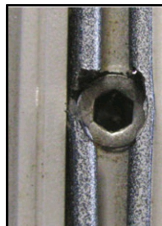
3. Vis Top-Roc mise en place.
