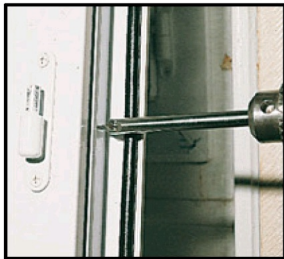
1. Percer la menuiserie Ø8,5 à 9 mm.
