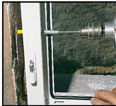
3. Enfoncer la vis Top Roc avec la cheville puis visser.
