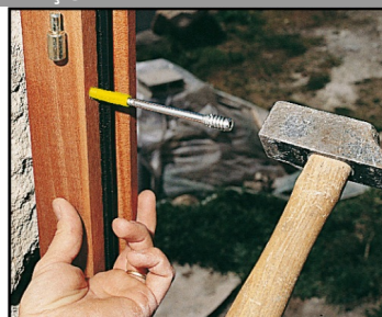
3. Enfoncer la vis montée sur la cheville dans la menuiserie
