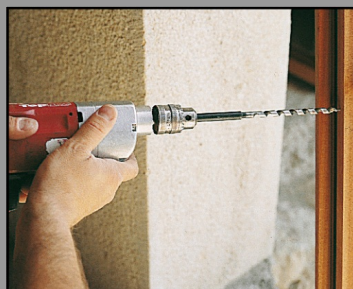
1. Percer la menuiserie au Ø8 mm
