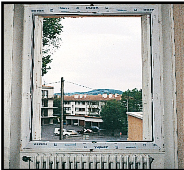
2. Positionner la menuiserie d'aplomb et de niveau après avoir préparé le dormant.
