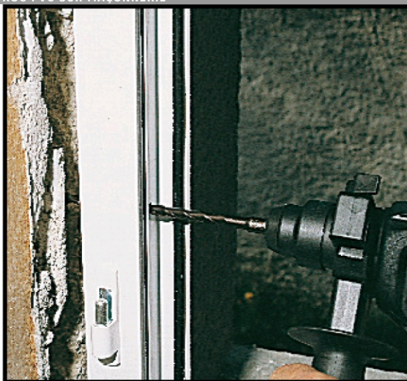
2. Percer un trou Ø8 mm dans le mur au travers de la menuiserie
