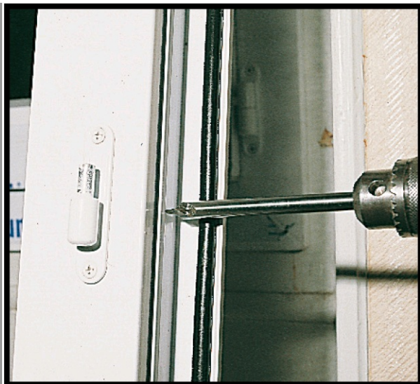
1. Percer la menuiserie au Ø 8 mm
