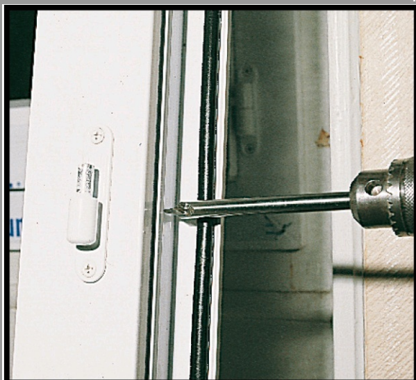
1. Percer la menuiserie au Ø 8 mm
